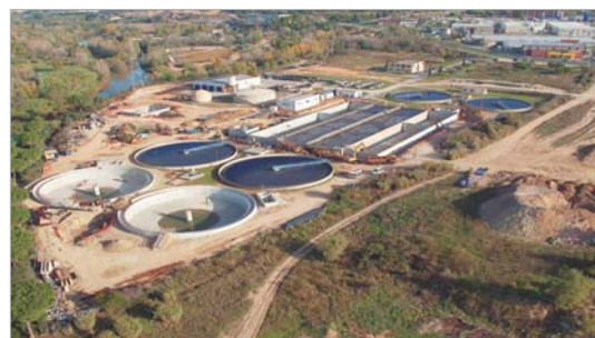
Hidrocanal es dedica a l'execució d'obres civils i hidràuliques. CEDIDA
